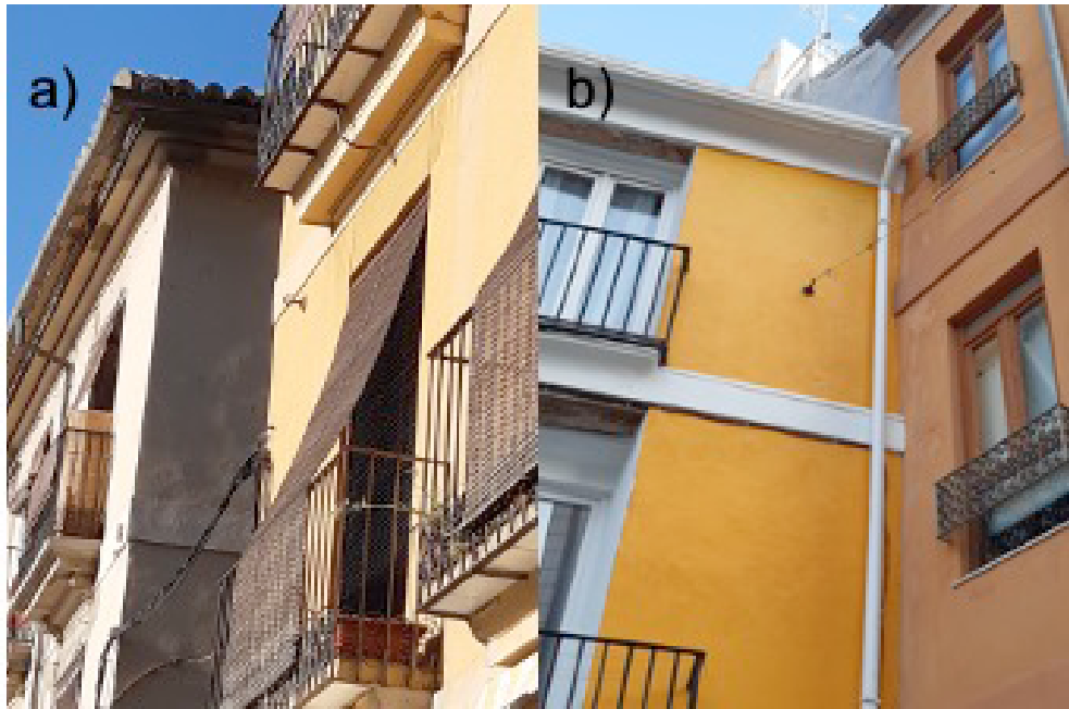
Figura 9.5. a) Gancho que sujetaban los tirantes de sujeción de la catenaria del tranvía; b) gancho y tirante. Se pueden reconocer en la calle Sagunto de Valencia.
