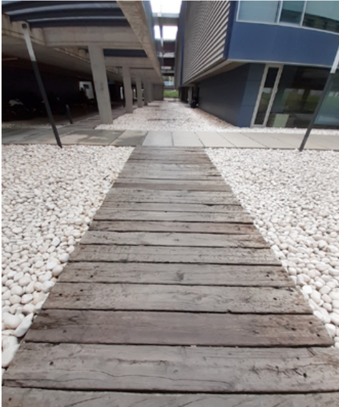
Figura 10.4. Traviesas de madera utilizadas como pavimento en el sendero peatonal que da acceso al Edificio 8B en la Ciutat Politècnica de la Investigació (CPI) de la Universitat Politècnica de València.
