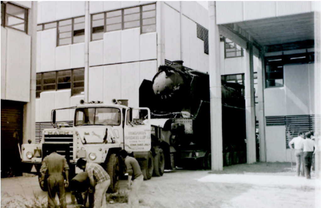
Figura 2.7. Inversión realizada por el camión que transportaba la locomotora, para situarla en las vías que se habían instalado para monumentalizar el conjunto de locomotora + ténfer. Fotografía: Juan Luis Llop (1982).
