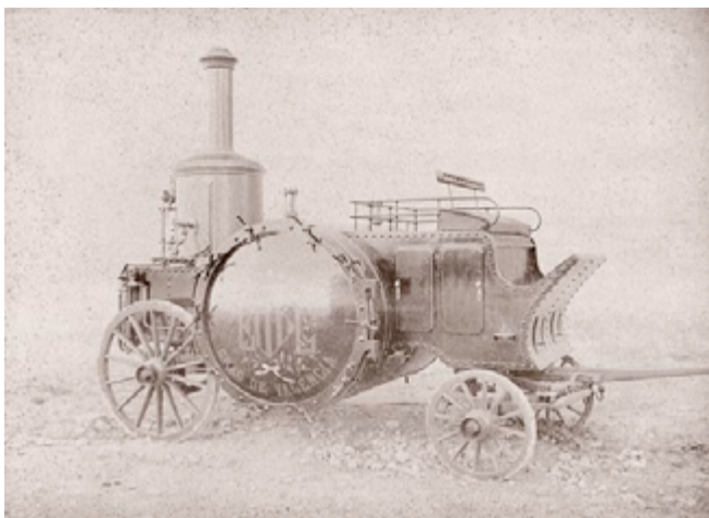
Figura 5.4. Estufa de desinfección a vapor, sistema “Lloret”, Valencia, c. 1890. Albúmina sobre papel, copia de época, 15.7 x 21.3 cm.
