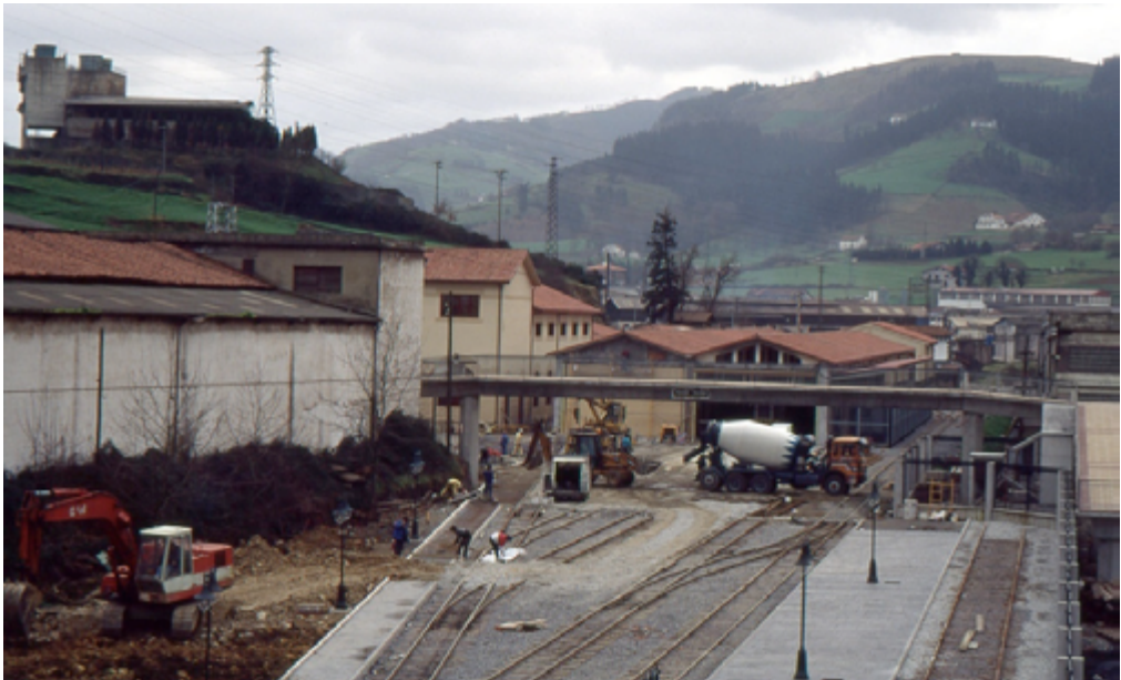
Figura 12.5. Obras de la segunda fase del Museo Vasco del Ferrocarril. Año 1993. Fotografía de Juanjo Olaizola Elordi.
